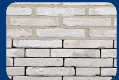
gevoegd metselwerk vs gelijmd metselwerk
