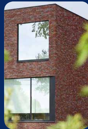
rode gevelsteen en grijs buitenschrijnwerk
