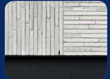
metselwerk horizontaal en verticaal
