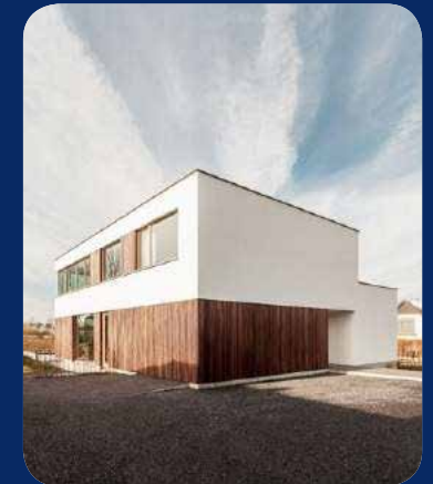
houten buitenschrijnwerk en houten gevelbekleding
