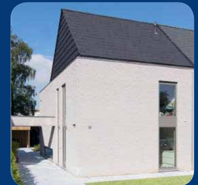
Dakkap aan 3 zijden in hetzelfde materiaal
