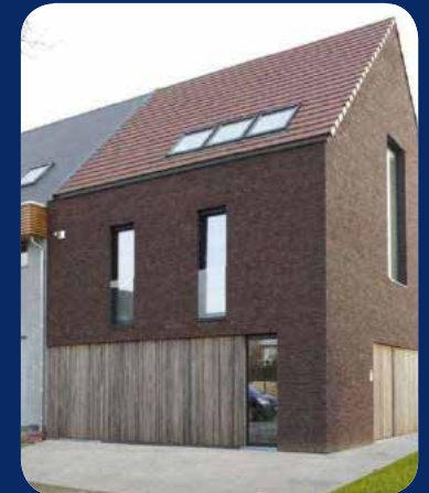
houten gevelbekleding verticaal geplaatst
